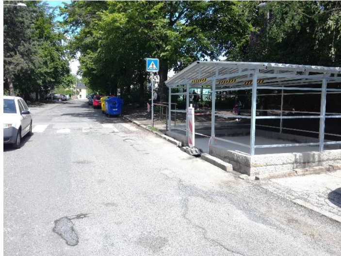
Obrázek 138 Čerstvě rekonstruovaný přístřešek na kontejnery zakrývající příchod k přechodu ve směru od školy
