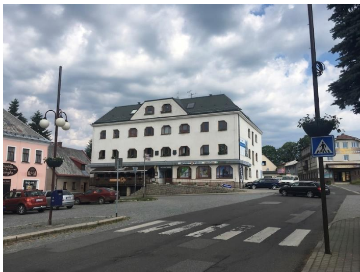
Obrázek 108 Chybějící osvětlení na přechodu pro chodce přes komunikaci č. 290
