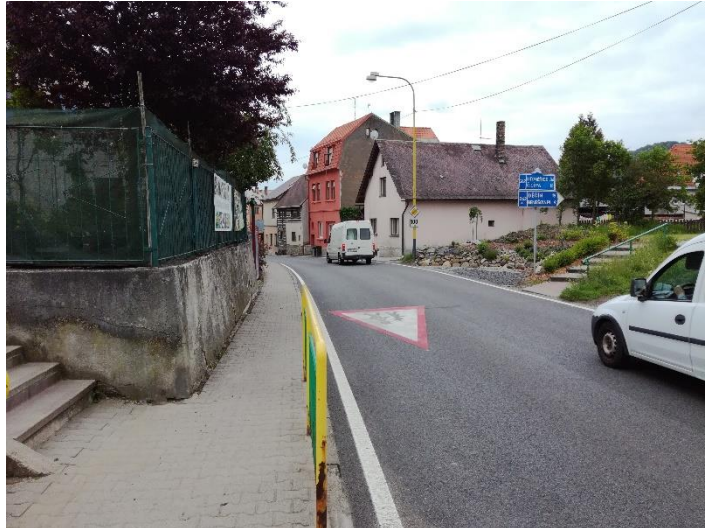
Obrázek 98 Rizikové místo přecházení přes ulici Lužická - malá viditelnost na vozidla přijíždějící od náměstí
