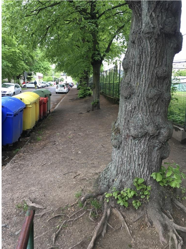
Obrázek 136 Chybějící chodník v ulici Bezová
