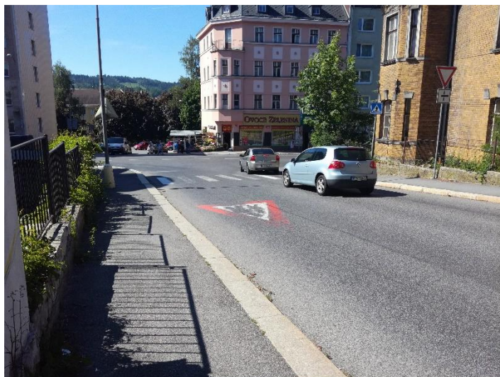
Obrázek 166 Vodorovné značení, které je navrhováno obnovit a doplnit i např. hranici křižovatky
