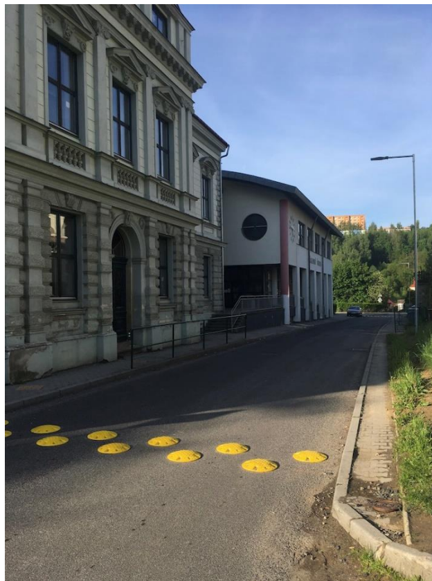
Obrázek 151 Zpomalující prvky a zábradlí u ZŠ Harcov
