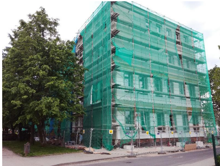
Obrázek 117 Budova ZŠ náměstí aktuálně procházející rekonstrukcí
