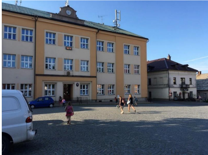
Obrázek 104 Budova ZŠ Vysoké nad Jizerou
