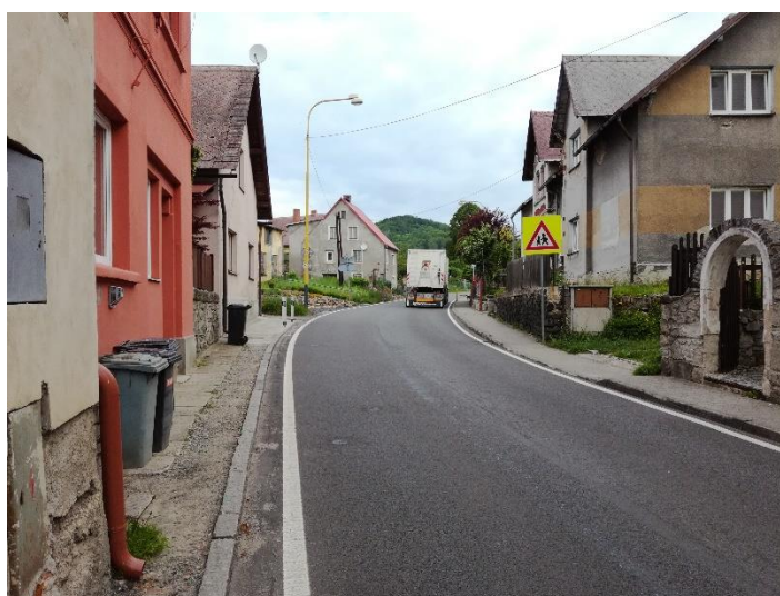
Obrázek 97 Rizikové místo přecházení přes ulici Lužická v místě projíždějícího kamionu
