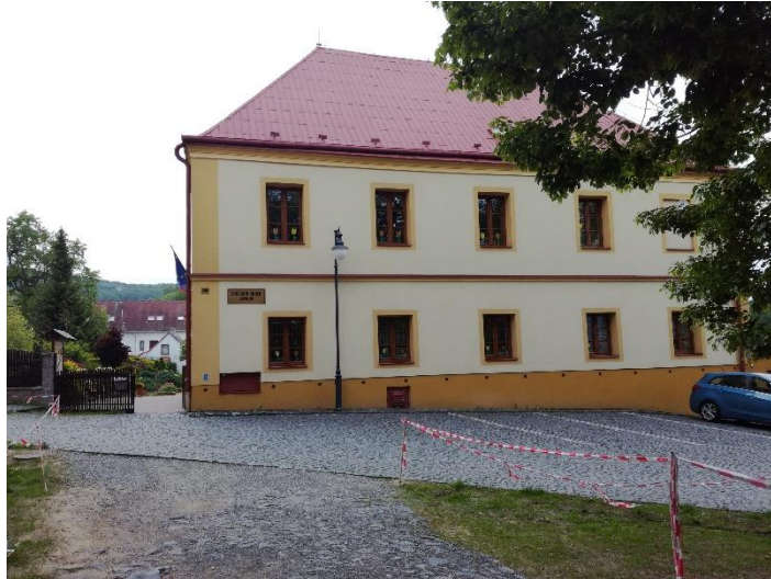
Obrázek 89 Vstupní branka do areálu budovy školy v pohledu od kostela
