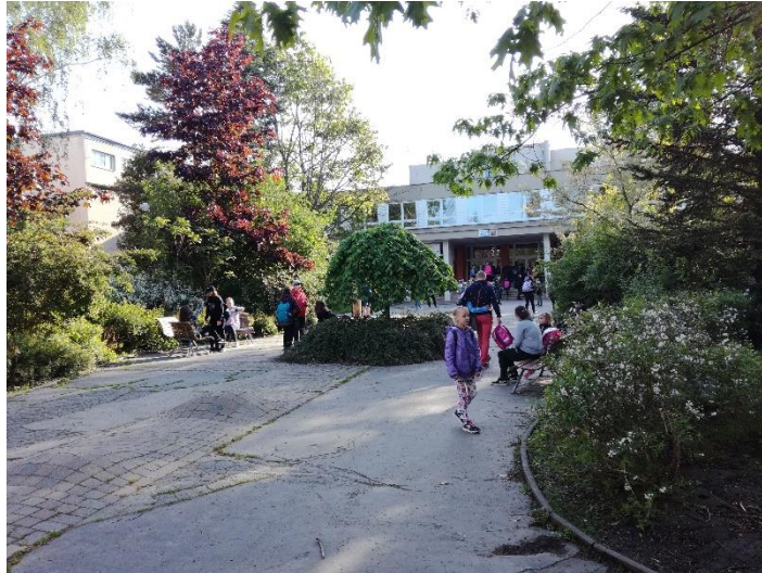
Obrázek 137 Vstup budovy ZŠ Sokolovská
